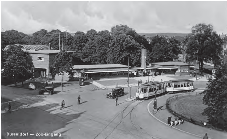
Abb. 3: Der Zooeingang von 1930. Die Gebäudeecke ganz rechts ist der letzte heute verbliebene Teil der ehemaligen Eingangsgebäude. Ganz links im Gebäude mit den Schett-Dächern befand sich das Löbbecke-Museum.
